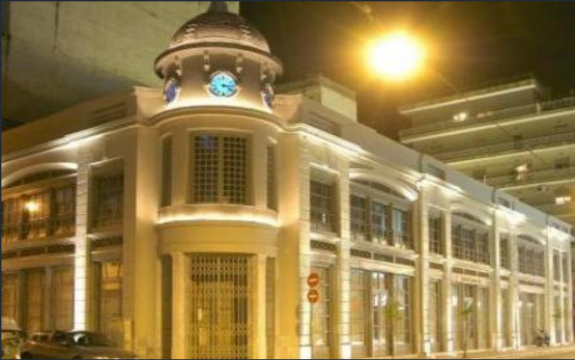
Ανακαινισμένο παλαιό εργοστάσιο επί της Αγ. Ανδρέου Πάτρα Ενοικιασμένο έως το 2026
