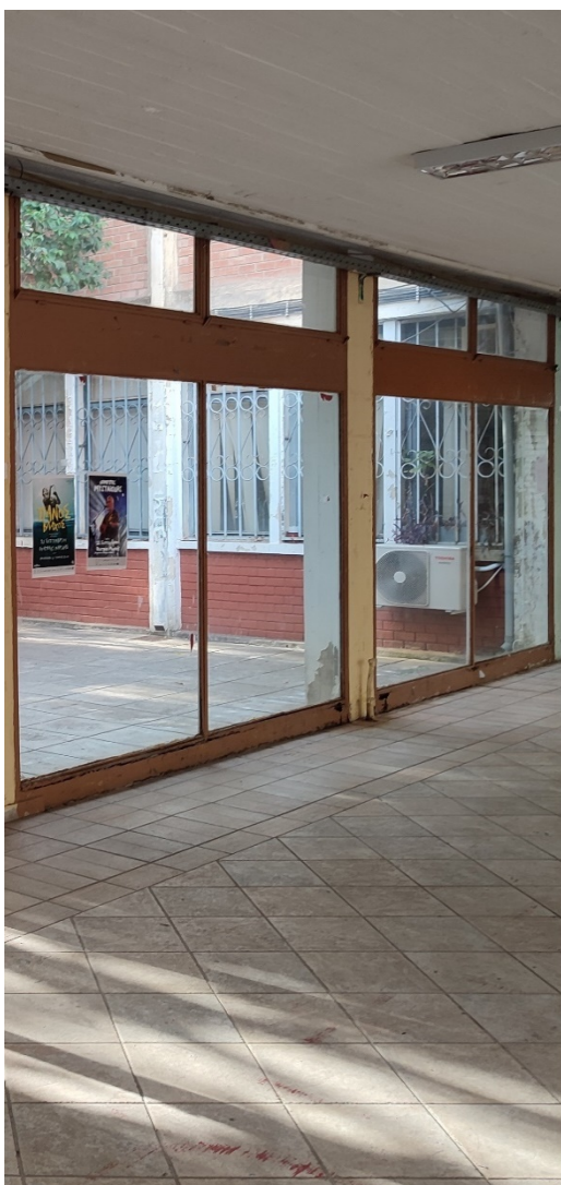
ΥΦΙΣΤΑΜΕΝΑ ΣΙΔΗΡΑ ΚΟΥΦΩΜΑΤΑ
