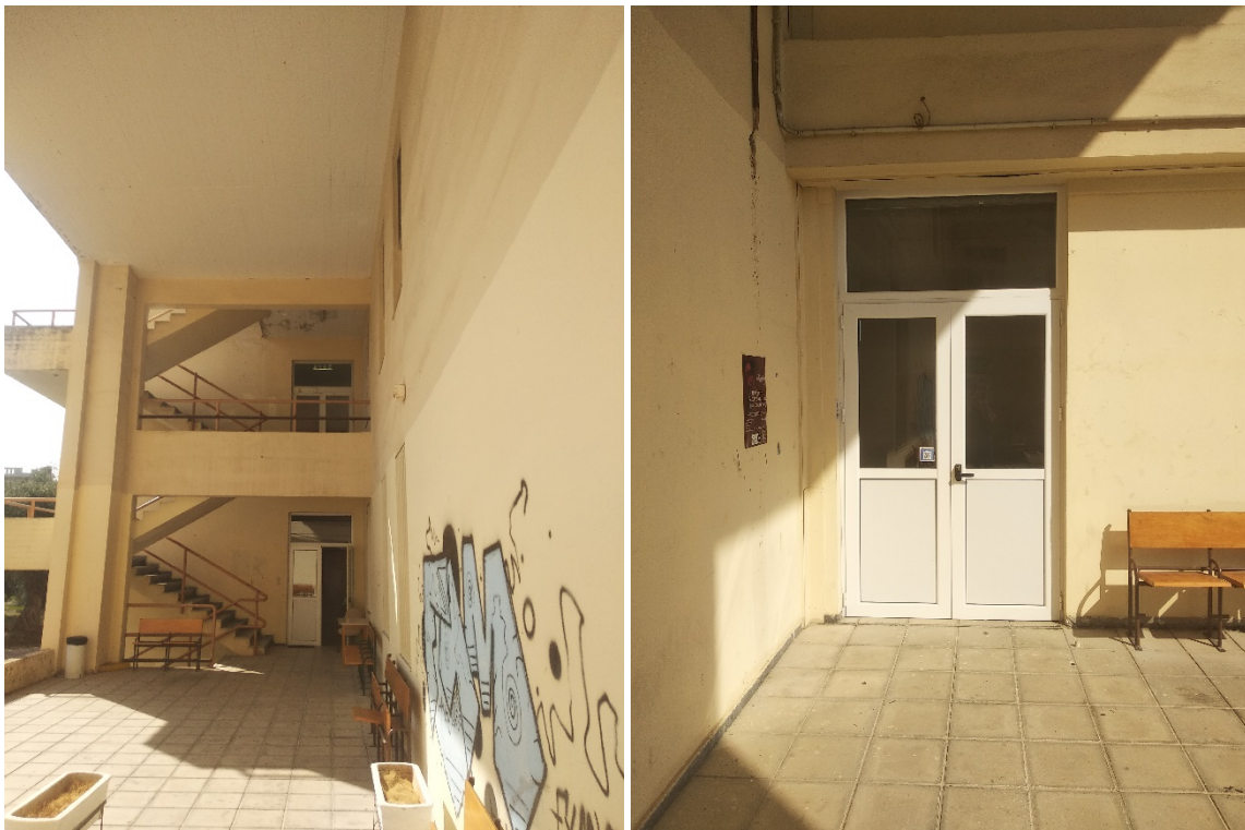
Φωτογραφία 1 : Υπάρχουσες θύρες αλουμινίου προς αποξήλωση με προσοχή και τοποθέτηση νέων (κάτω θύρα) και τοποθέτηση σε θέσεις που θα αποξηλωθούν οι υφιστάμενες (πάνω θύρα).
