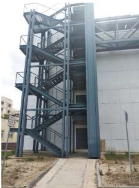
Φωτογραφία 1 : Θύρες στα μεταλλικά κλιμακοστάσια.
