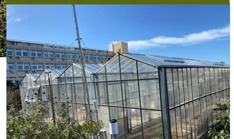
Το θερμοκήπιο του Πανεπιστημίου Πατρών μετά την ανακαίνιση. Ενσωματωμένα στην οροφή του θερμοκηπίου τα ημι-διάφανα φωτοβολταϊκά πλαίσια.
